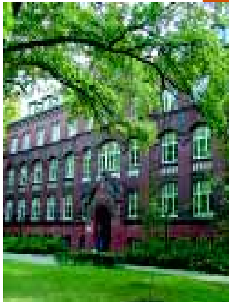
Erverdig bygningsmasse i Biotech Campus Potsdam.
