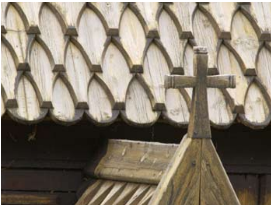
Takdetalj fra den rekonstruerte Øye stavkirke (ca. 1125), Vang i Valdres. Foto: © Bjørn Rørslett / NN / Samfoto.
